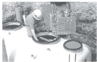
合併浄化槽のタンクのすえつけ
